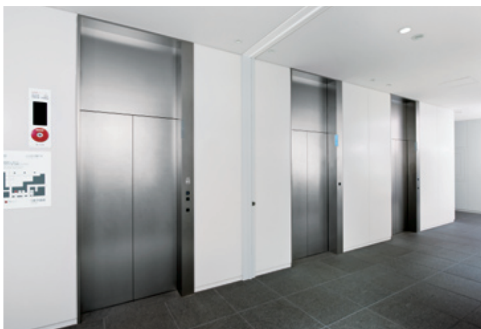
エレベーター・1階ホール
