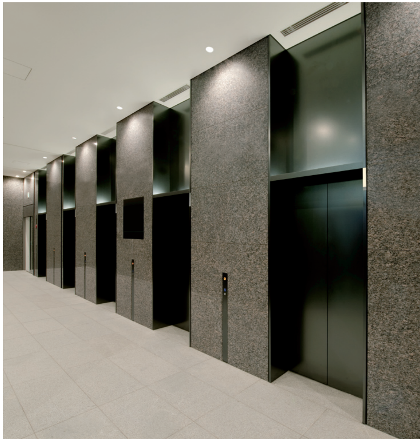
エレベーター・1階ホール
