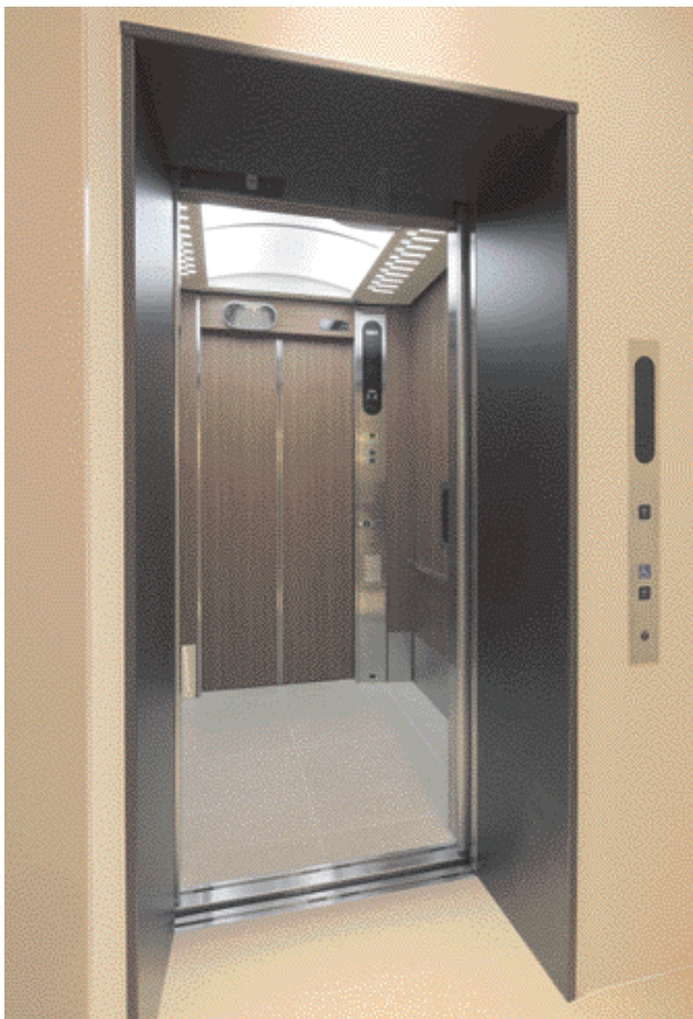
乗用エレベーター・地下1階
