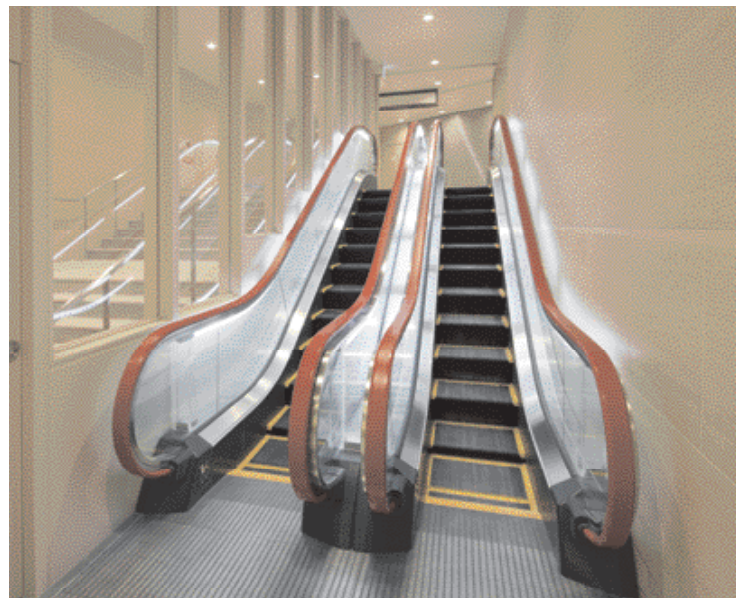
エスカレーター・地下1階
