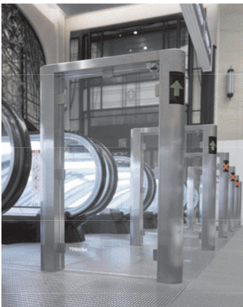
1階-地下階連絡 6台並列エスカレーター・1階
