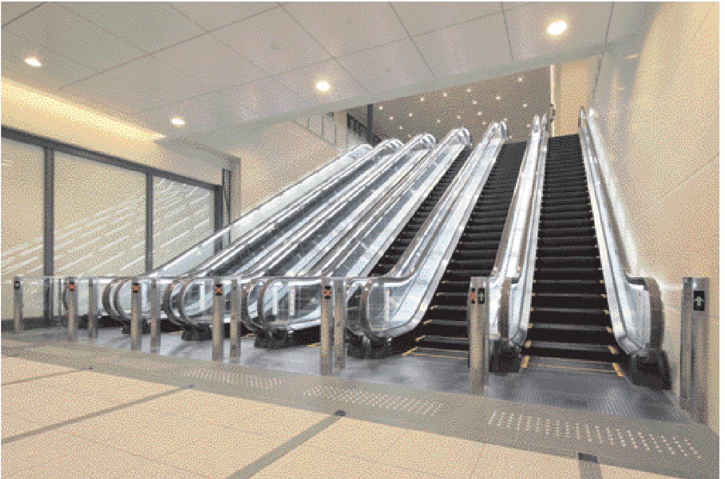
1階-地下階連絡 日本初6台並列エスカレーター
