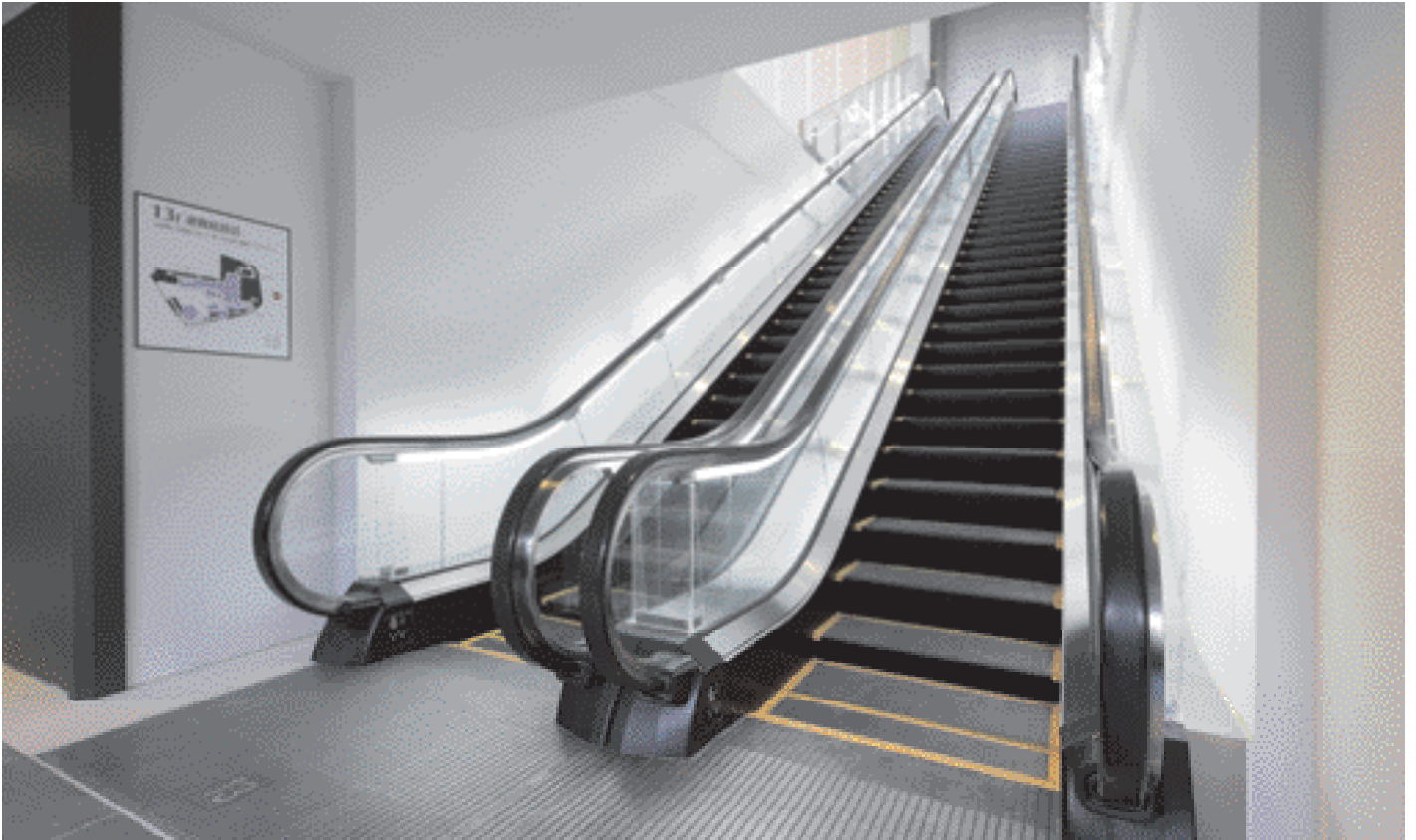
13階-15階連絡エスカレーター
