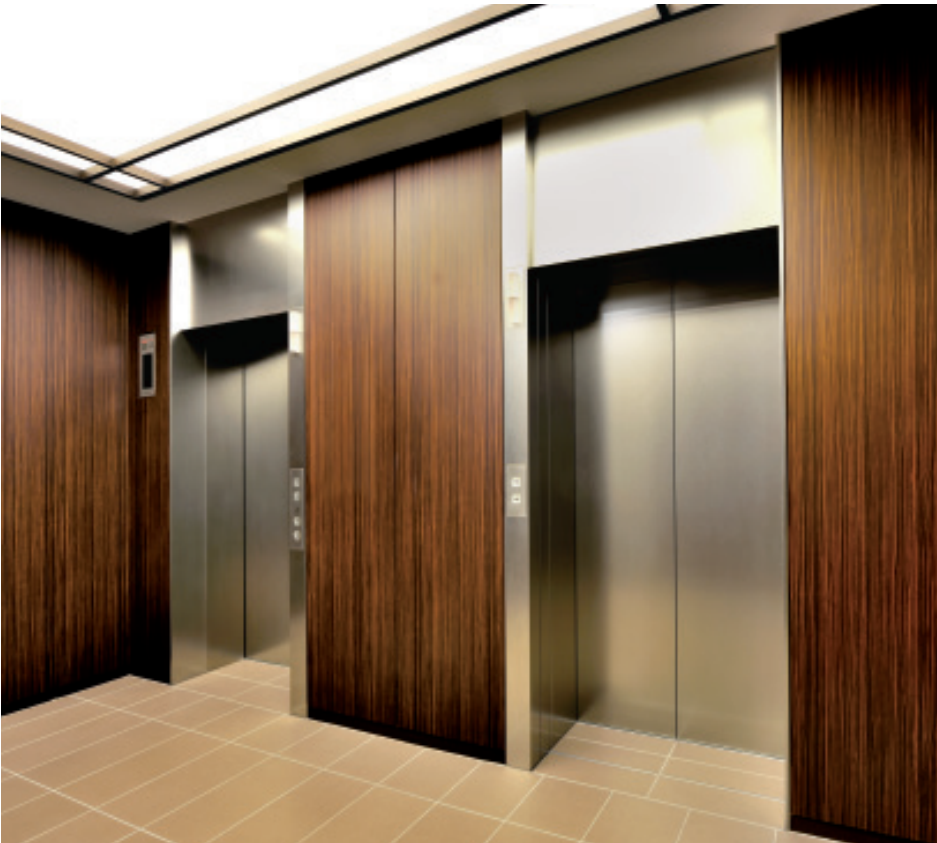
乗用・非常用エレベーター (No.2、3)・2階ホール
