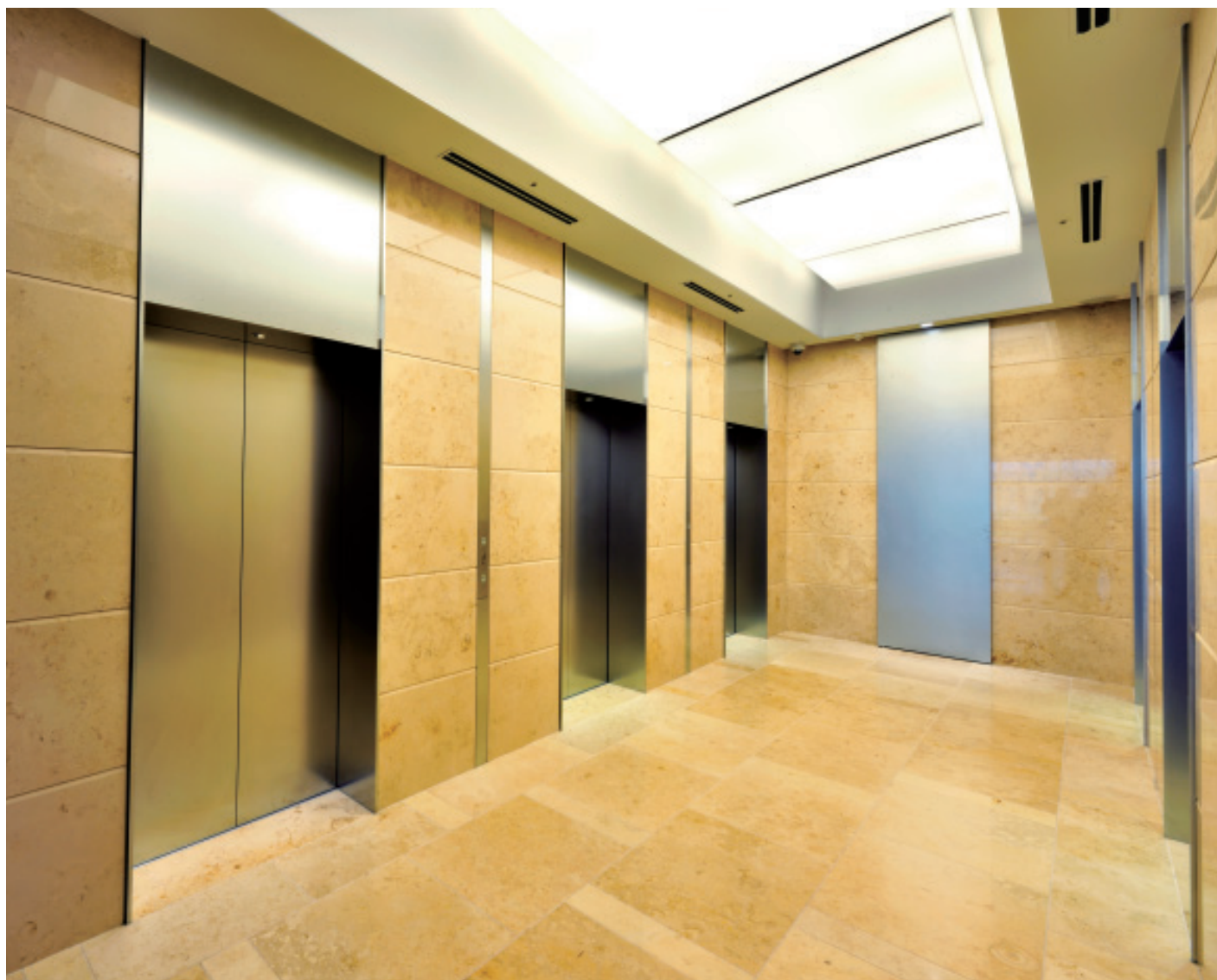
乗用15人乗りエレベーター (No.5~10)・ロビー階ホール
