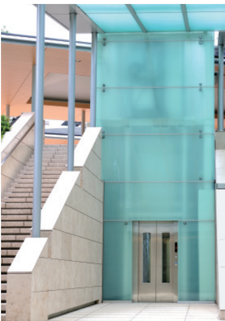
乗用15人乗りエレベーター (No.11)・昇降路 (屋外)
