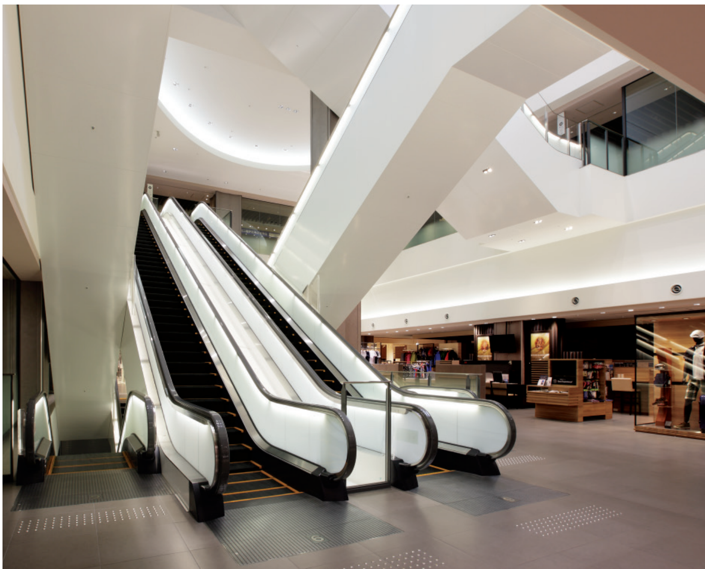
エスカレーター・9階
