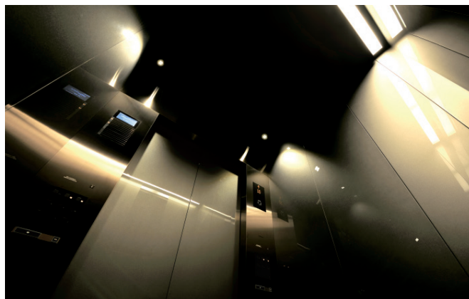
乗用エレベーター・かご室天井
