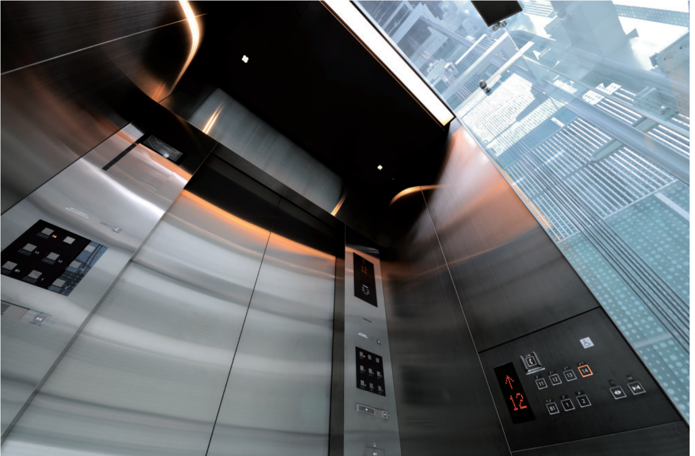
展望用エレベーター・かご室天井
