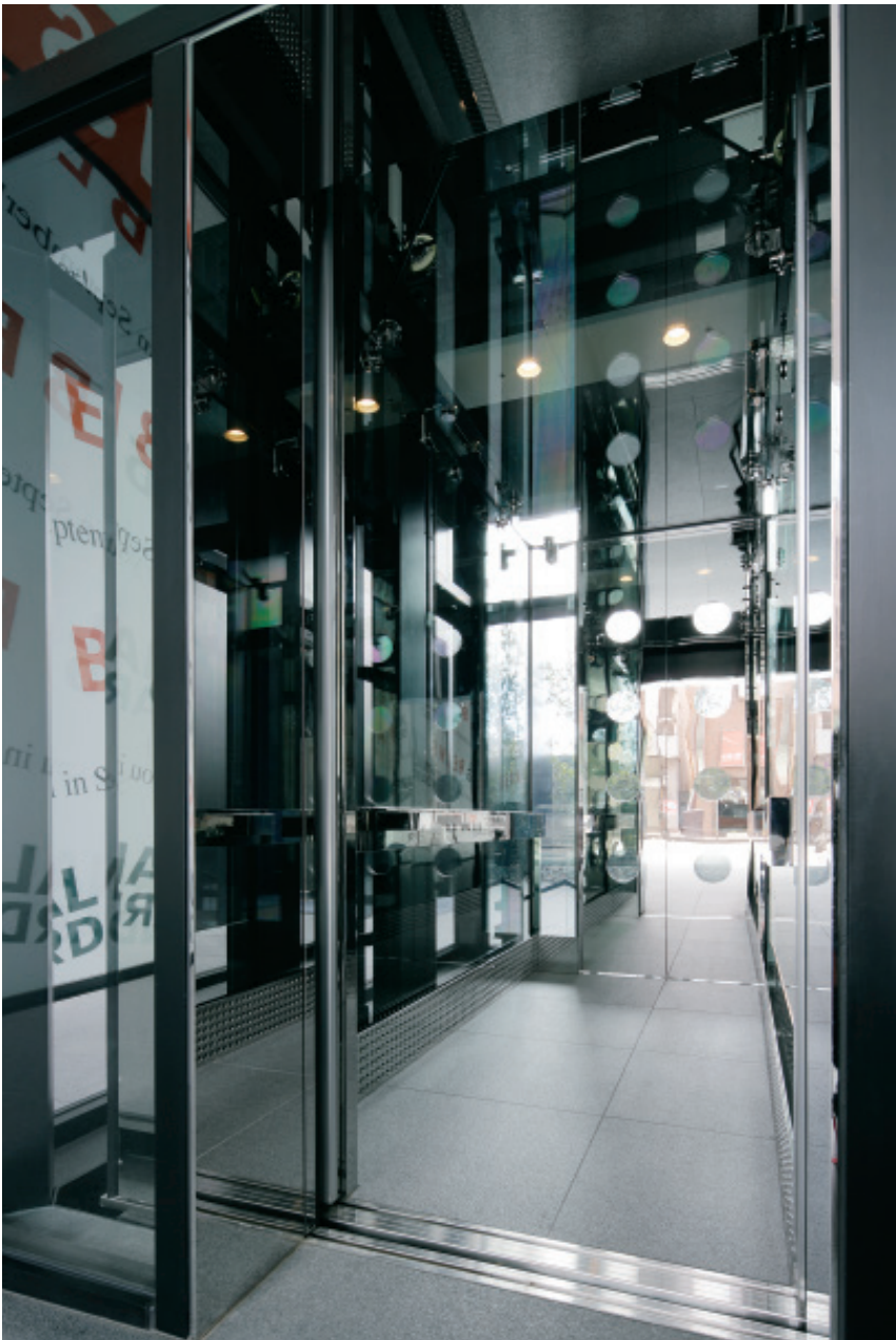
展望用エレベーター・かご室(前後両開きシースルーエレベーター)
