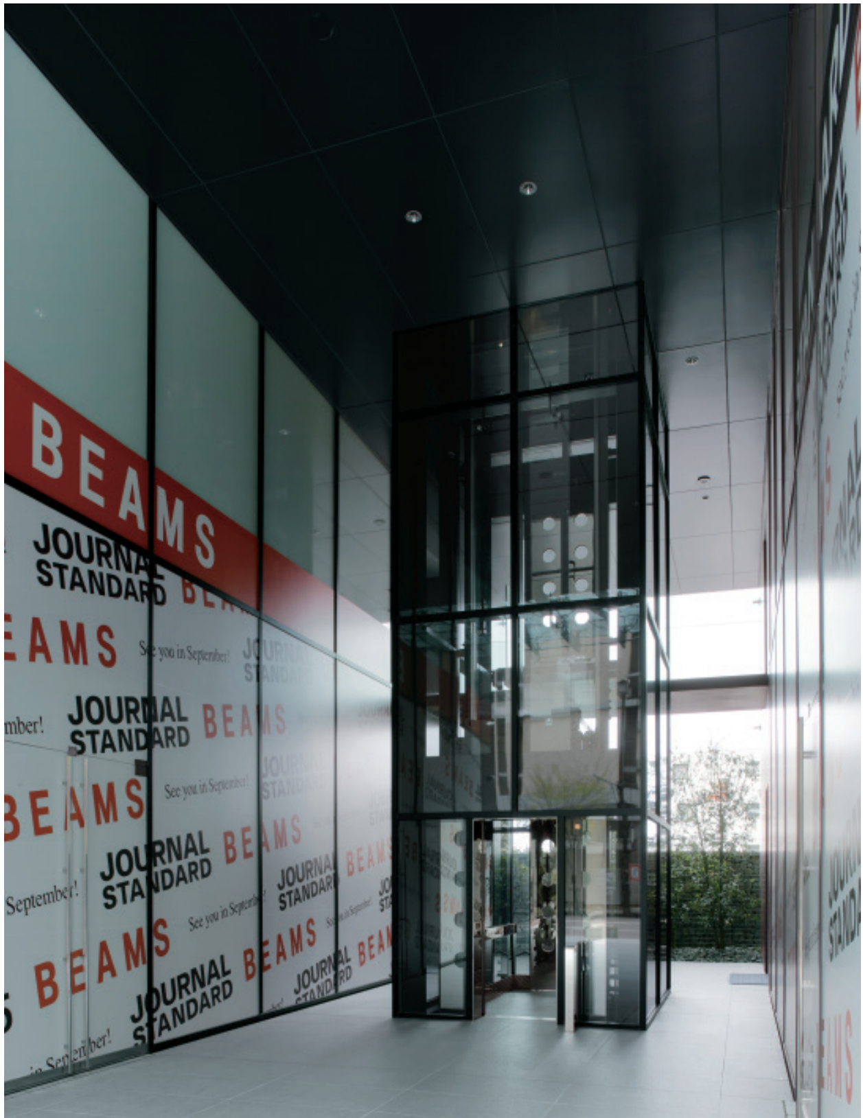
展望用エレベーター・昇降路(前後両開きシースルーエレベーター)
