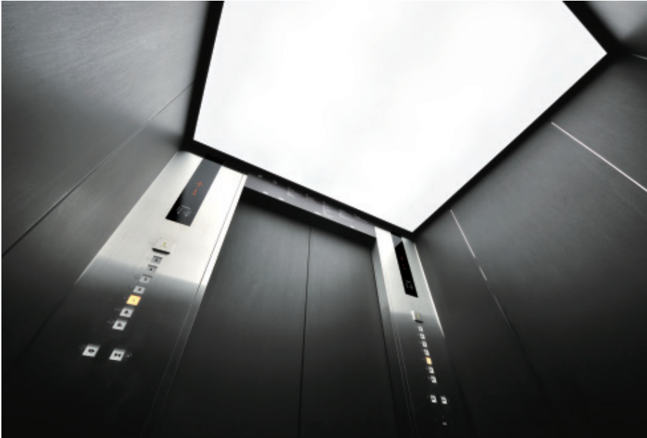
乗用24人乗りエレベーター・かご室天井(サザンスカイトワーモール八王子)
