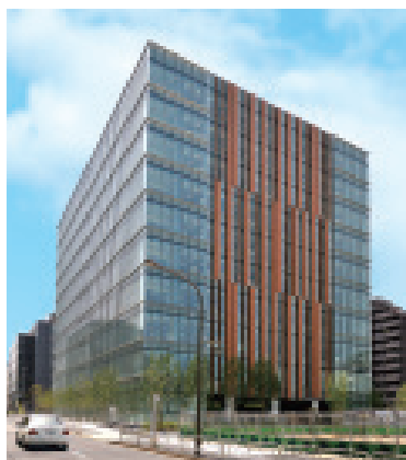
建物外観(ウエスト3棟)
