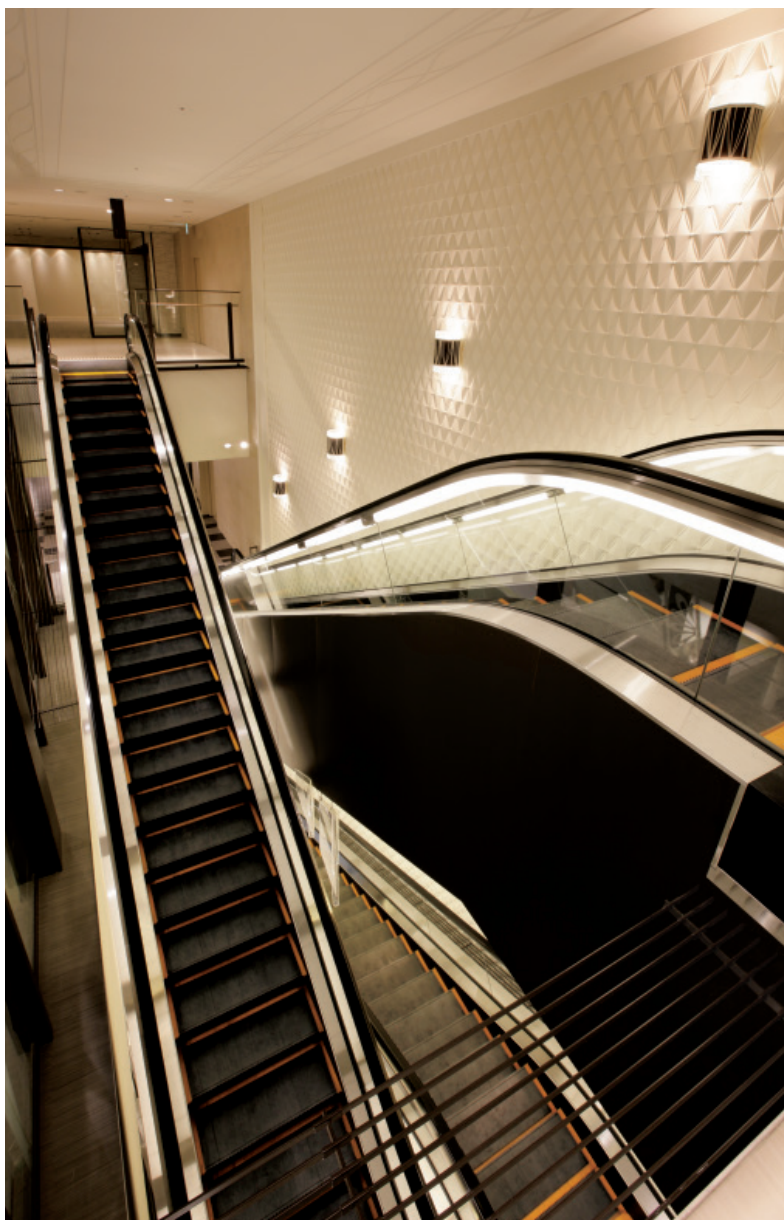
エスカレーター・12階
