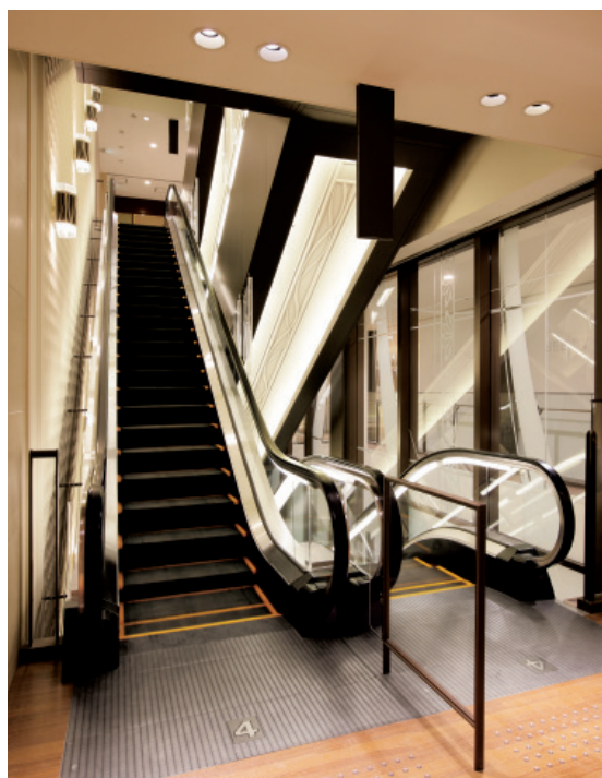
エスカレーター・4階
