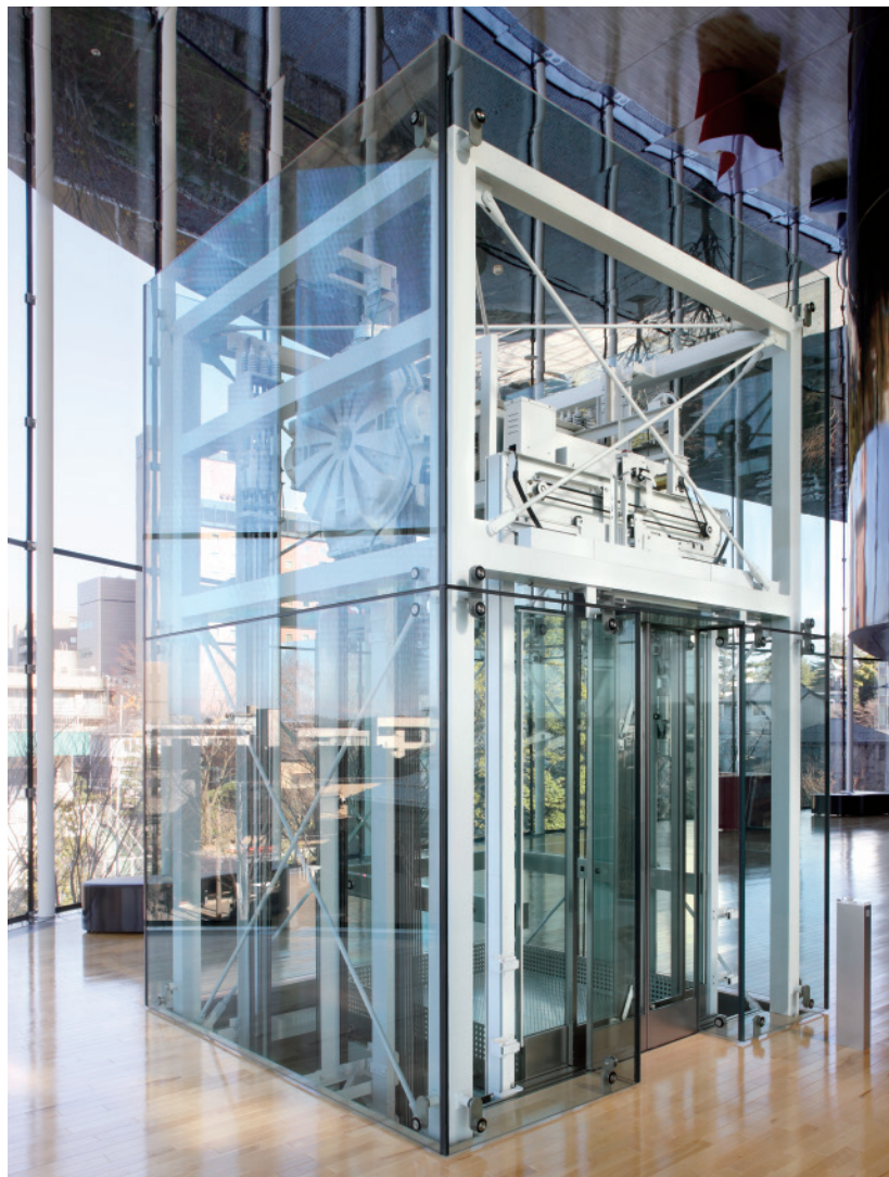
展望用エレベーター
