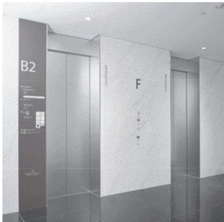
乗用 15 人乗りエレベーター・地下 2 階ホール
