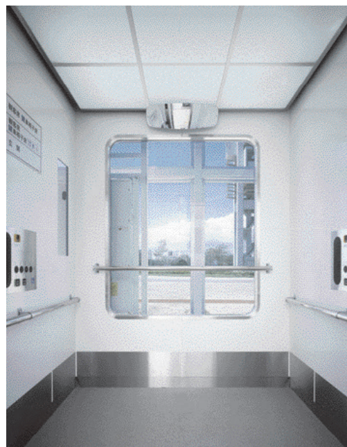
展望用エレベーター・かご室
