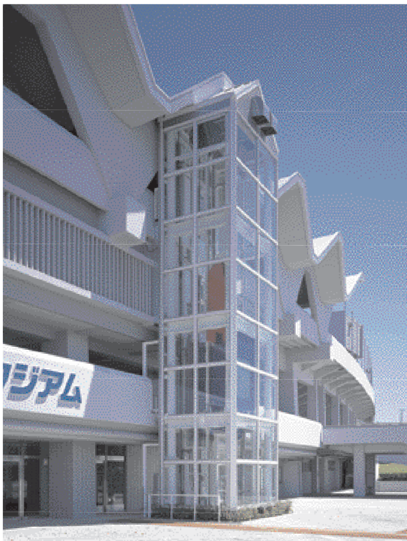
展望用エレベーター・外観
