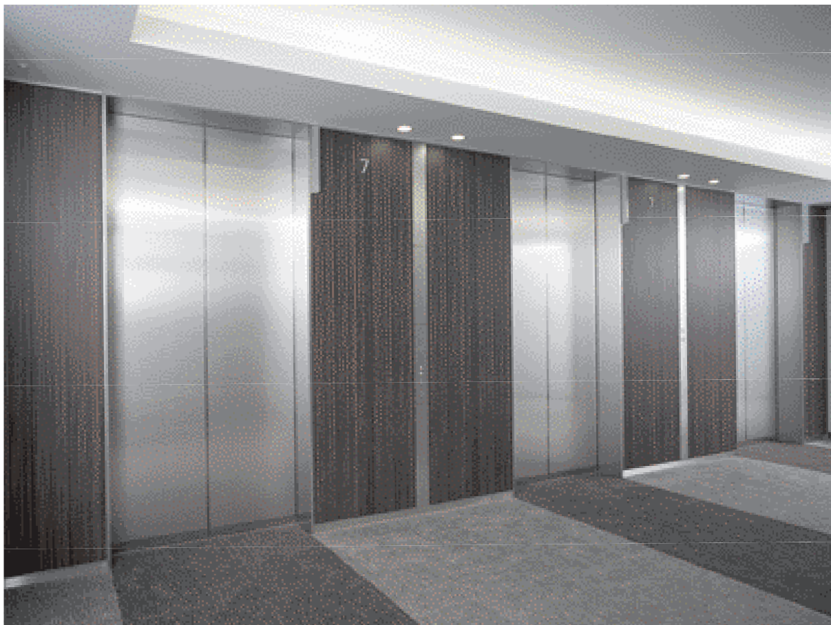
乗用24人乗りエレベーター・7階ホール（ミッドタウンイースト・オフィス）
