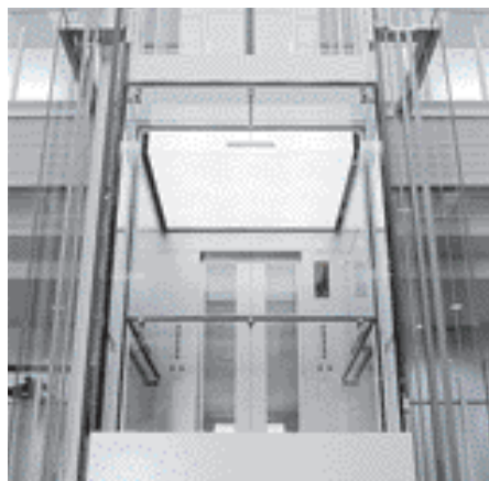
展望用エレベーター・かご室
