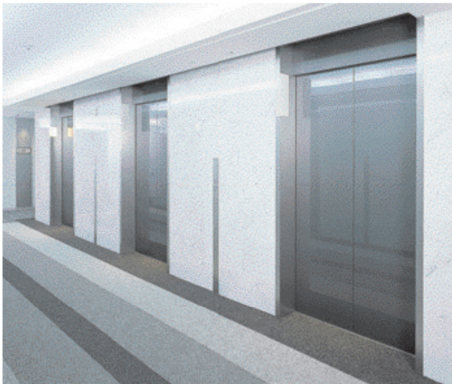
乗用 28 人乗りエレベーター・3 階ホール
