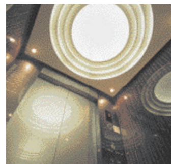
乗用エレベーター・かご室天井
