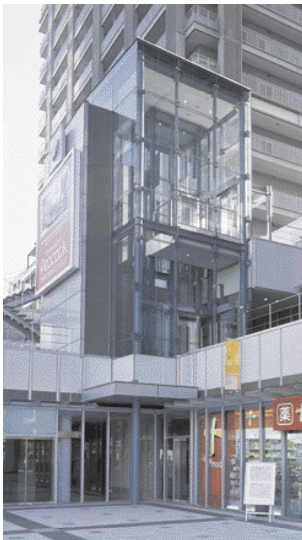
展望用エレベーター（住宅棟）・昇降路外観
