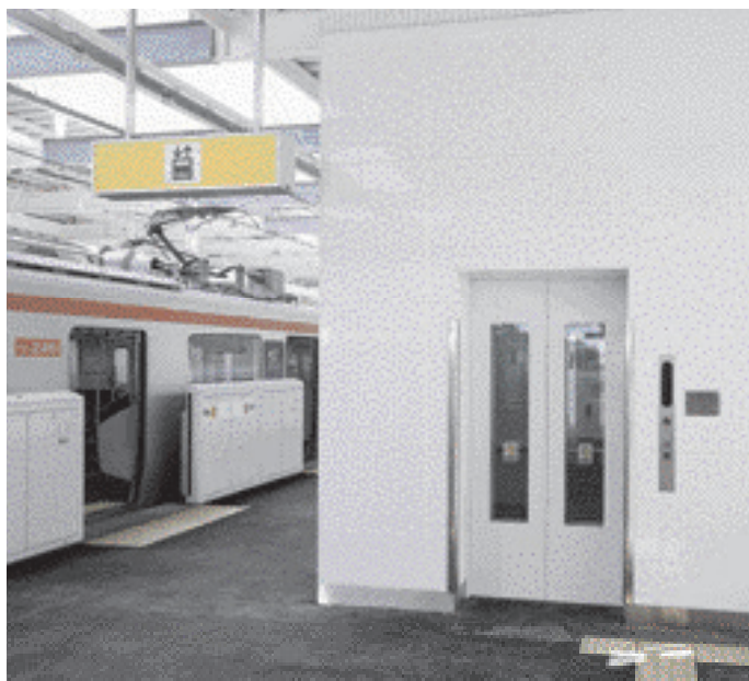
乗用エレベーター・ホーム階（柏の葉キャンパス駅）
