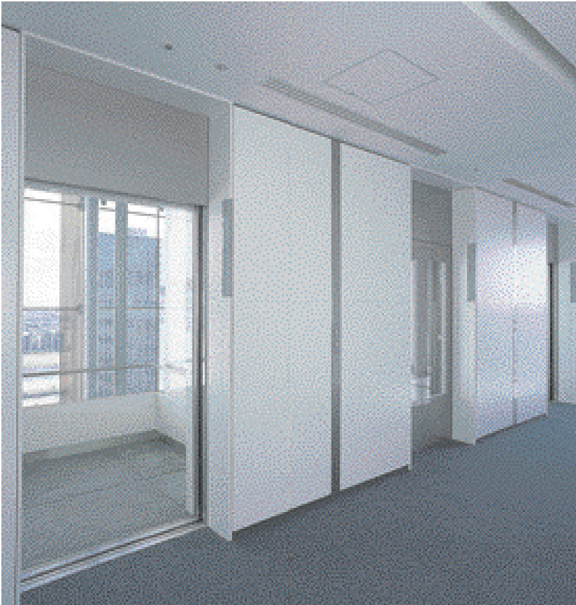
乗用27人乗り(展望用)エレベーター・25階ホール
