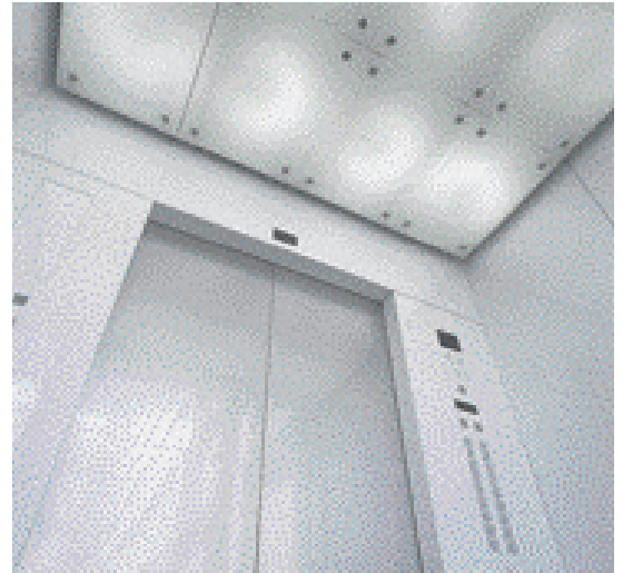
乗用27人乗り(展望用)エレベーター・かご室天井
