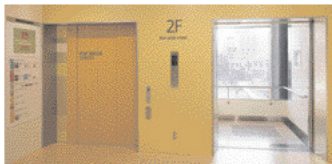
展望用エレベーター(駅ビル棟)・2階ホール
