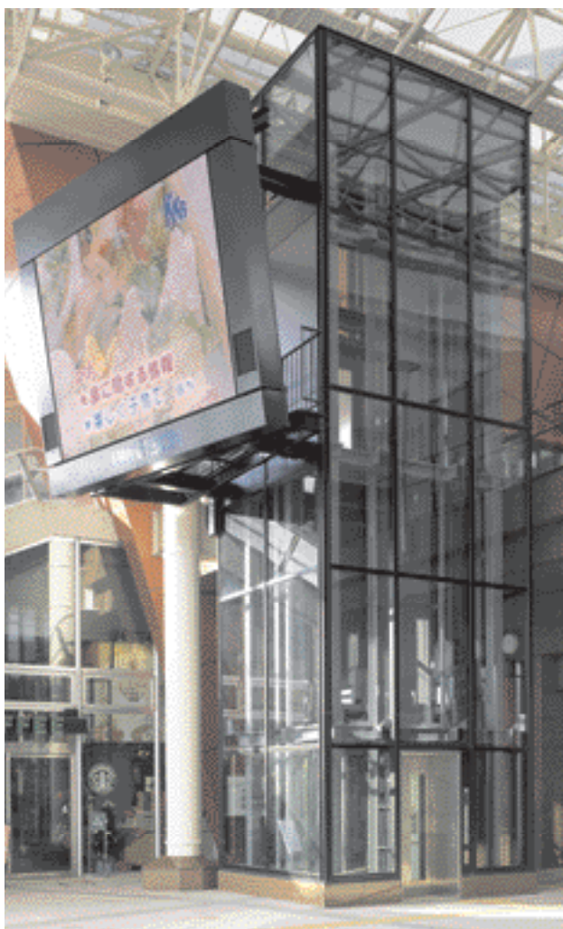
展望用エレベーター(プラザ)・昇降路
