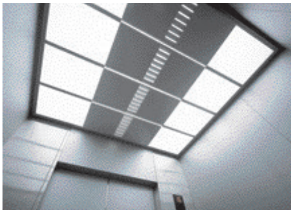
乗用17人乗りエレベーター・かご室天井（タワー棟）
