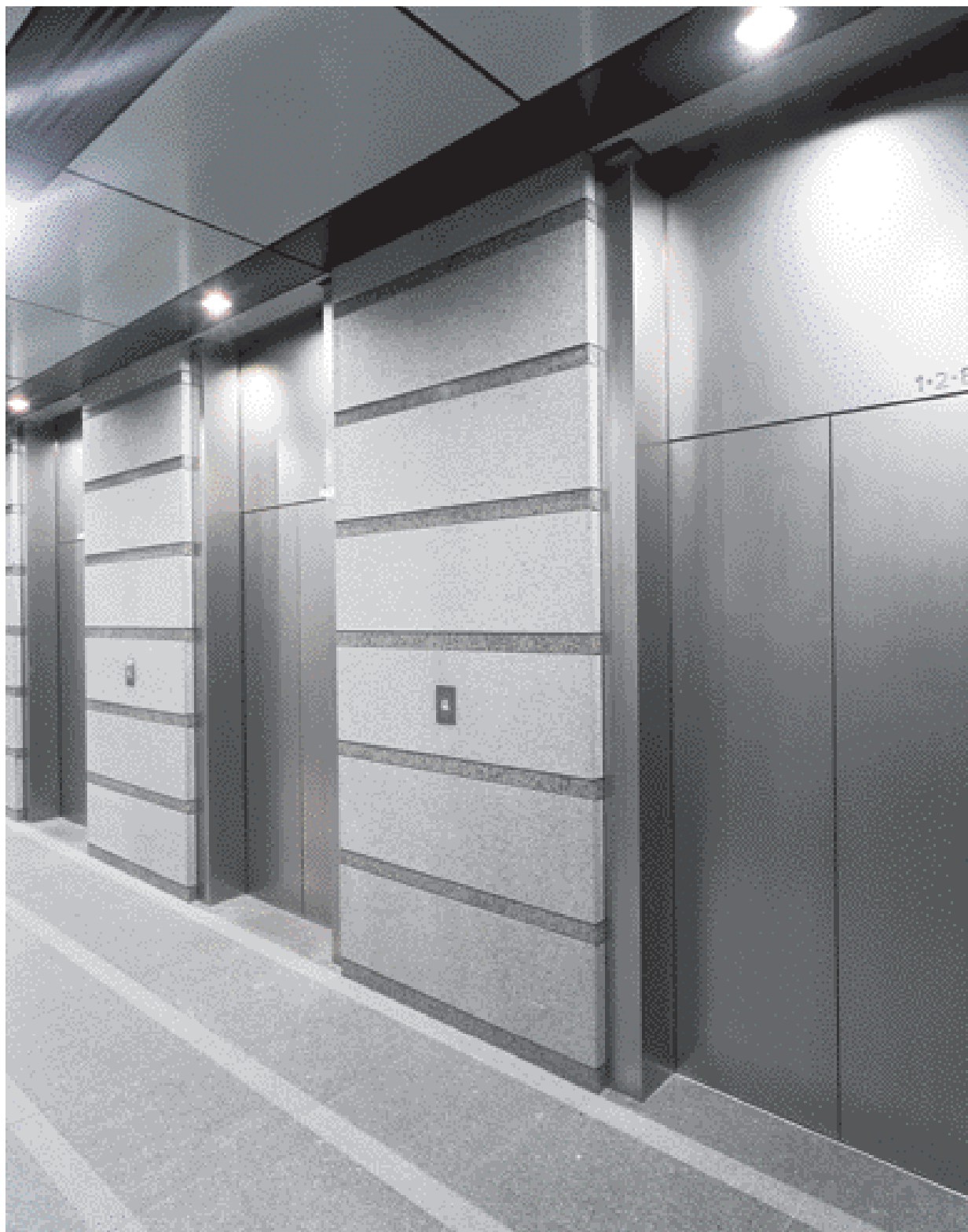
乗用17人乗りエレベーター・1階ホール（タワー棟）
