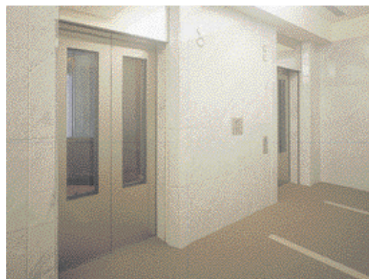
展望用エレベーター・2階ホール
