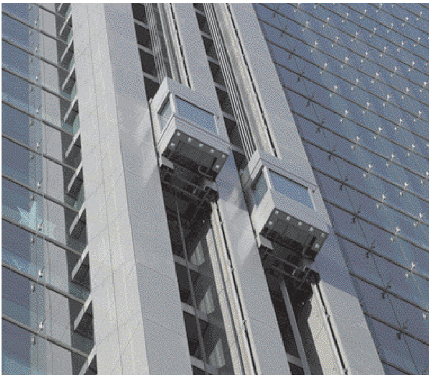
会館シャトル(屋外形展望用)エレベーター
