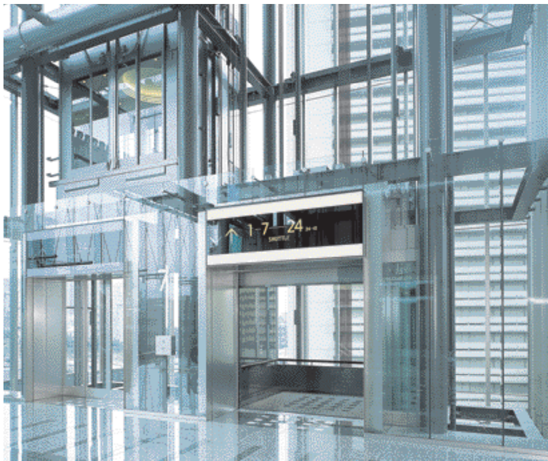
高層シャトル(展望用)エレベーター・7階ホール
