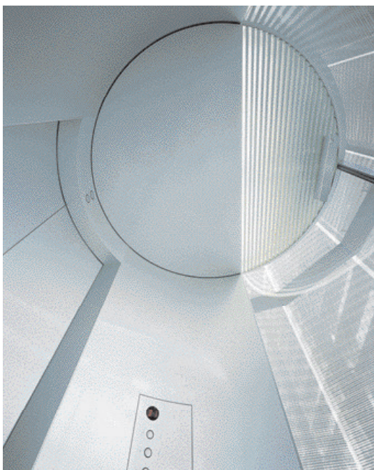
円形展望用エレベーター・かご室天井
