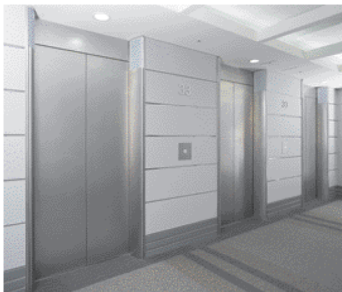
乗用エレベーター・ホール(33階)
